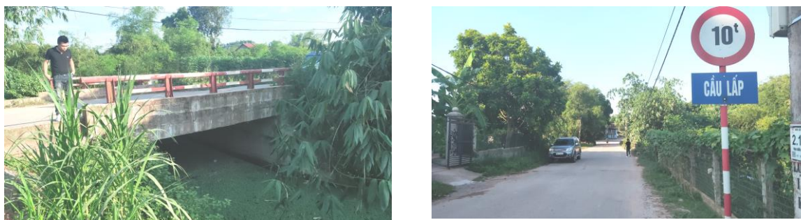
Hình 1. 2. Hiện trạng cầu Lấp
